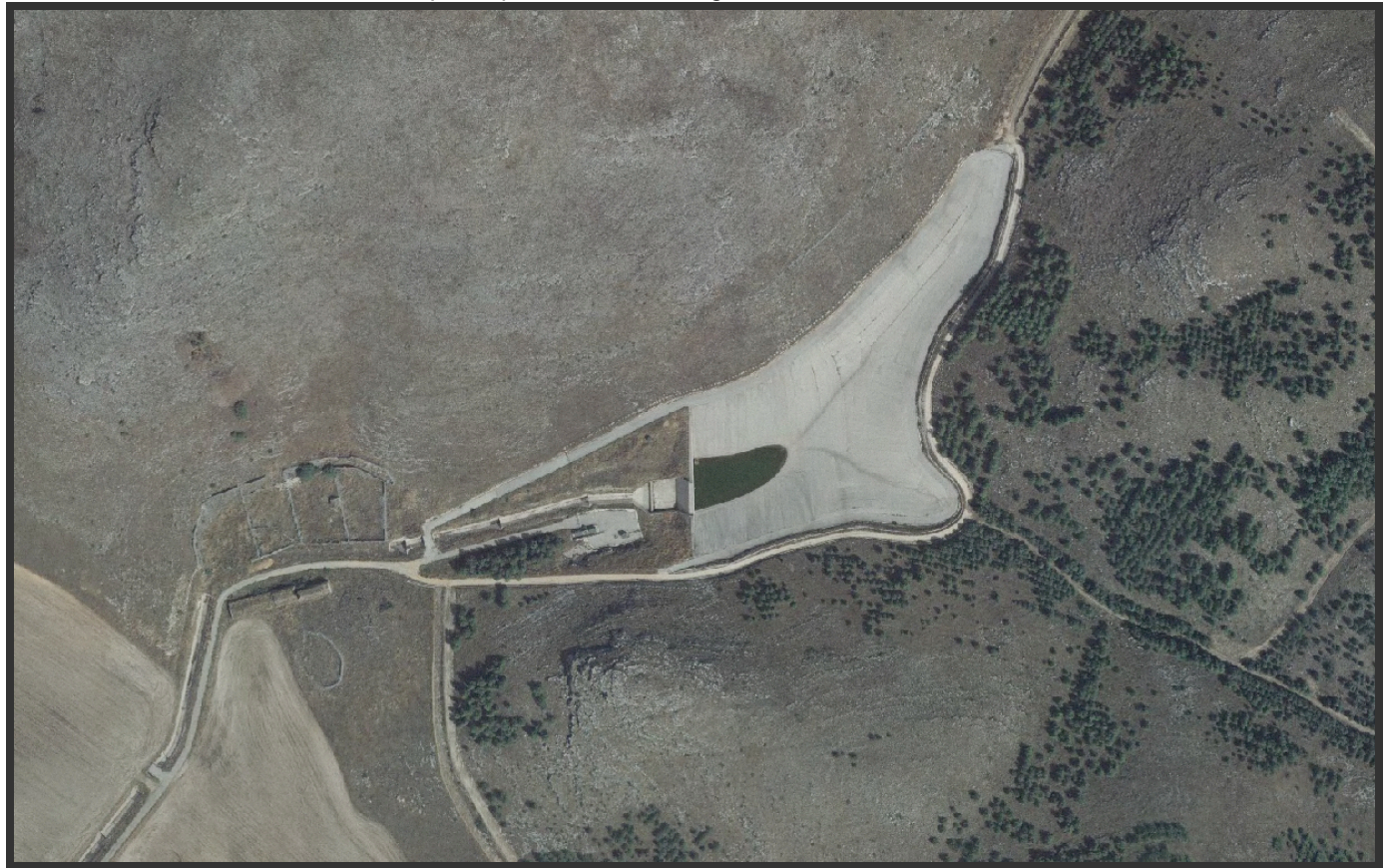
Bacino artificiale di raccolta delle acque superficiali, alta murgia.
